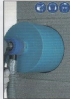
**B4.** Mantelsteinöffnung jetzt mit größerer Bohrkronen vollständig aufbohren. Wichtig: Profilrohr dabei nicht beschädigen oder anbohren!
