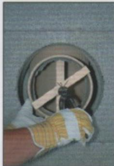
**B6.** Rauchrohrzarge am Profilrohr feströdeln
