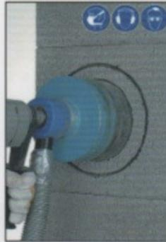
**B3.** Für den inneren Querschnitt, mit kleiner Bohrkronen, vorsichtig durch Mantelstein und Profilrohr bohren
