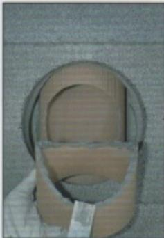
**B5.** Nach Reinigen beider Kittflächen Schiedel-Fugenkitt auf die Rauchrohrzarge auftragen
